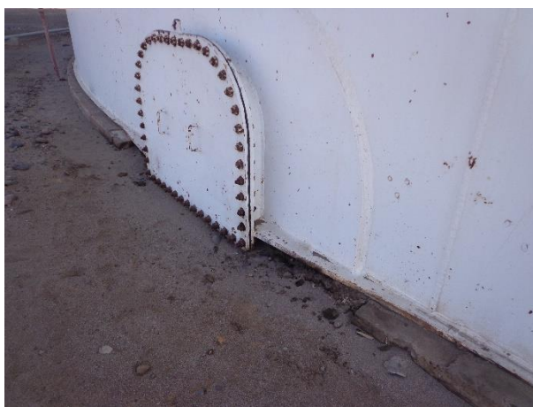
Foto 4. Entrada de mantenimiento TK-20001 Y TK-20002 (son similares)
